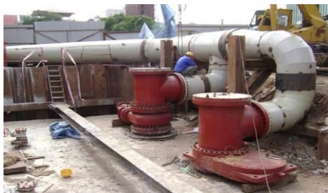
Nước đã đi qua đường ống tạm bypass
