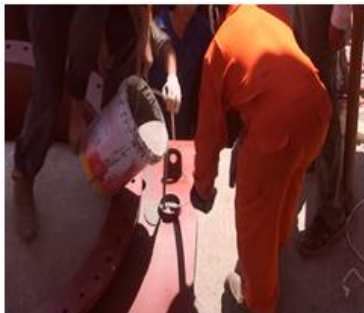
Đổ vữa bê tông làm kín kiềng ốp
