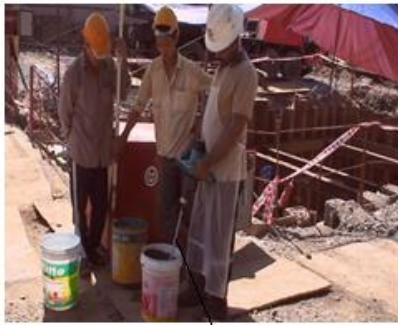
Khuấy trộn vữa bê tông
